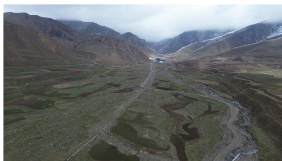
初麻乡人饮管网现状
