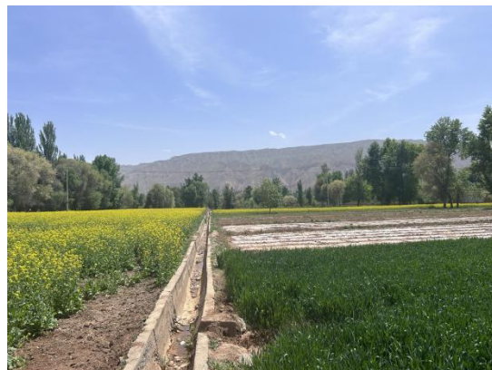
甘都镇渠道维修现状
