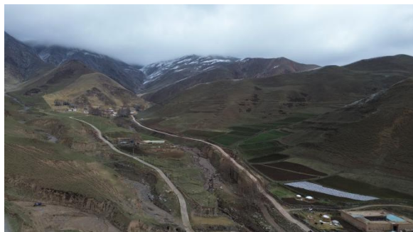
初麻乡人饮管网现状
