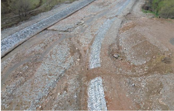
引水口防冲坎现状
