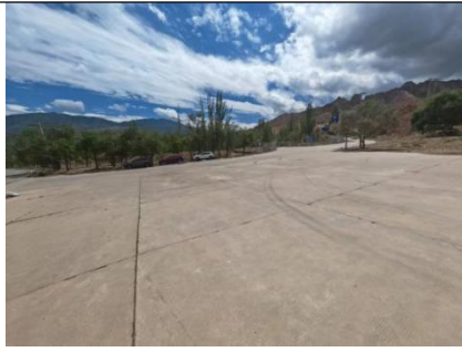
借用加油站区水泥地坪做指挥部
