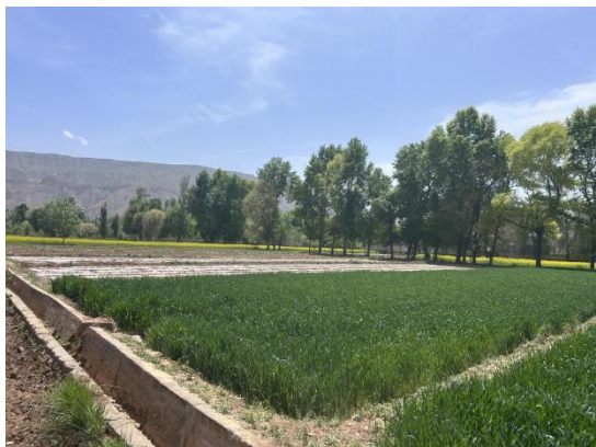
甘都镇渠道维修现状
