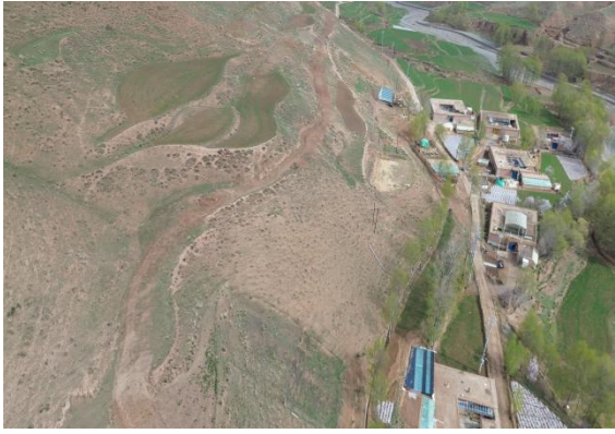
引水口防冲坎现状
