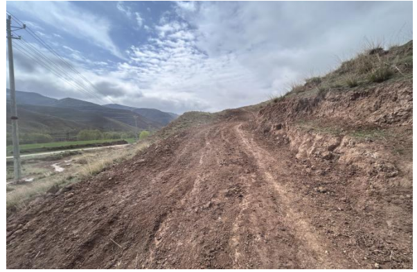
引水口防冲坎现状
