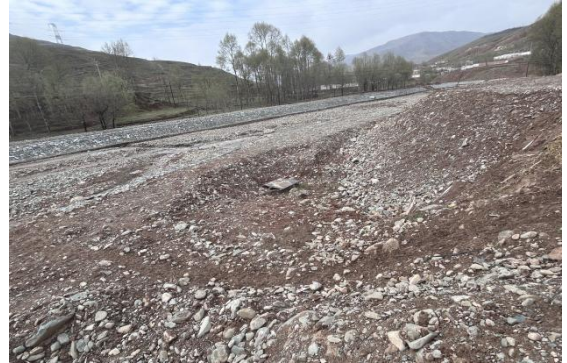
引水口防冲坎现状
